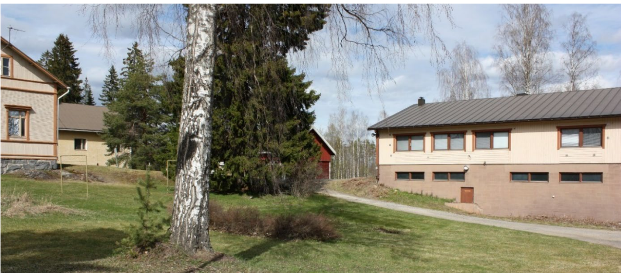
Kuva 4. Näkymä Linnantieltä oikealla tekninen virasto, vasemmalla kunnantalo.
